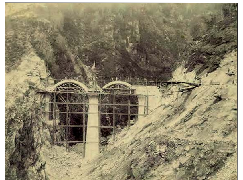
Il getto del doppio arco del Ponte Grand sulla Valle delle Crane ancora sorretto dall'imponente impalcatura, è giunto al termine. Il risultato è festeggiato dalle maestranze allineate sull'impalco dove è stata issata una bandiera. Si può inoltre intuire che le pietre lavorate per la costruzione del manufatto furono ricavate dal fianco della montagna. Fotografia di Angelo Monotti, Cavigliano, scattata il 28 ottobre 1899 (prop. priv.)
