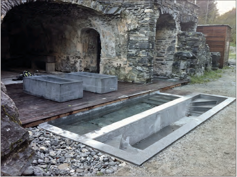
Bagni di Craveggia. Le nuove vasche esterne (fotografia LMC)
