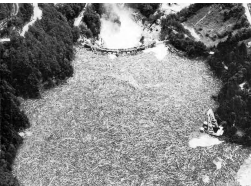
La diga di Palagnedra il giorno seguente l'alluvione del 7.8.78.
