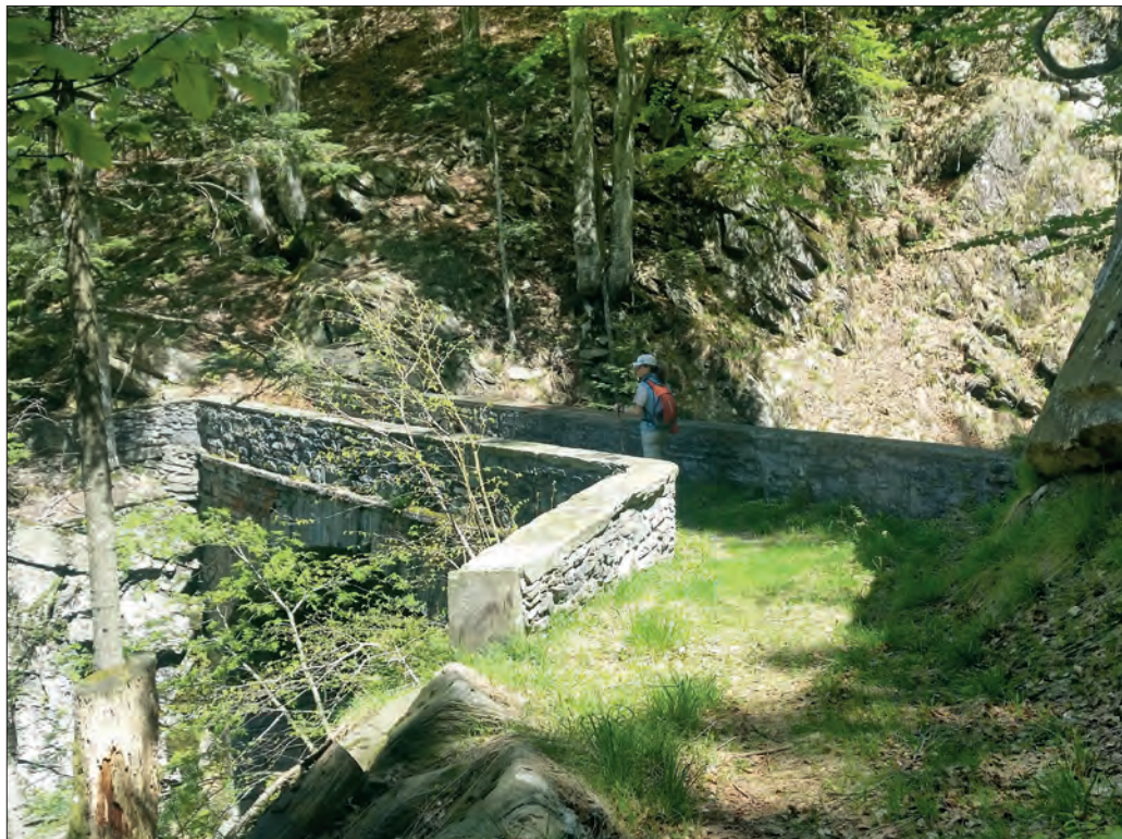
Ponte sul rio Garba.
