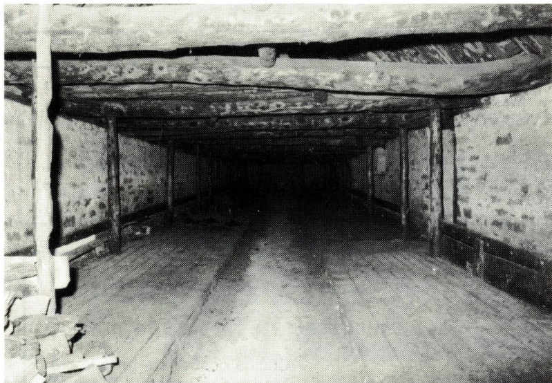
Alpe Salei: l'interno dello stallone
