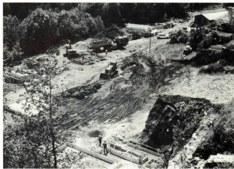
Istallato il cantiere a Russo, sono iniziati i lavori di fondazione
