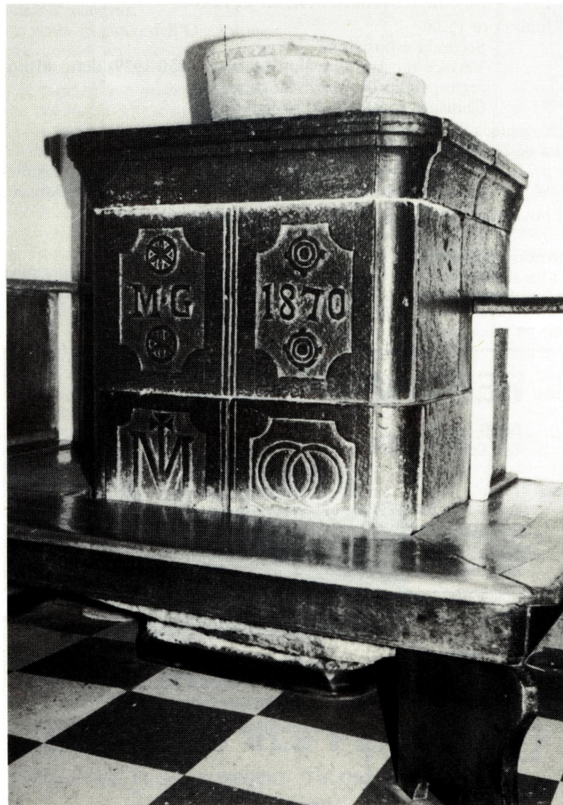
Pigna in pietra ollare tipica della 2.a metà dell'800 a Peccia (valle Lavizzara) con panchina in legno. Sul piano superiore si scorgono due laveggi torniti. (Foto Museo di Cevio)
