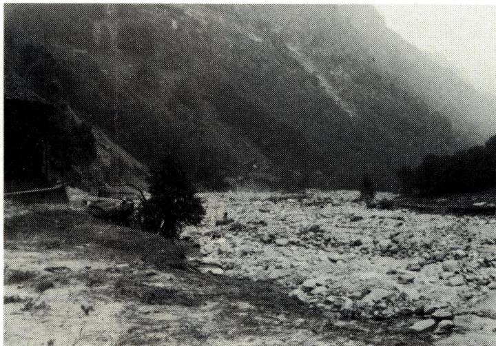
Zona «Pertusio-Geria»: dopo l'alluvione.
