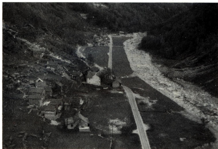
Zona «Chià-Zardin»: dopo la sistemazione.
