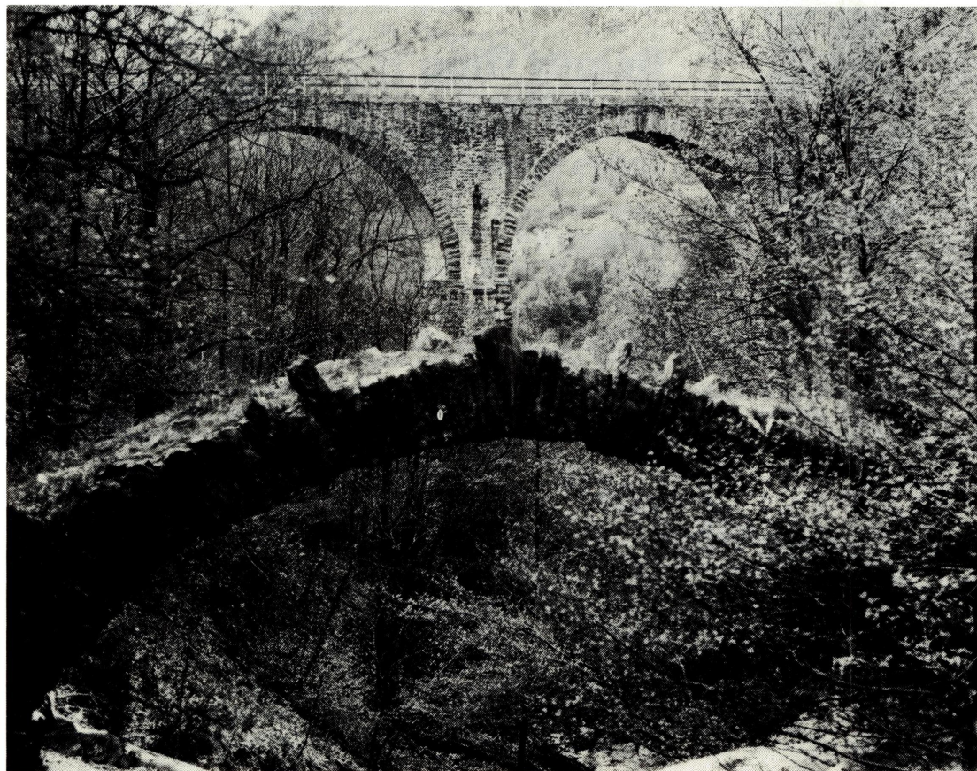
L'antico e il «nuovo» ponte sul riale del Cratolo, sul fondo la frazione «Vosa».
