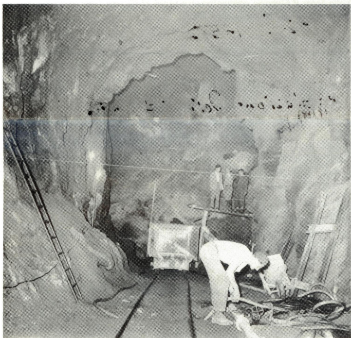
22 agosto 1952: lo scavo
