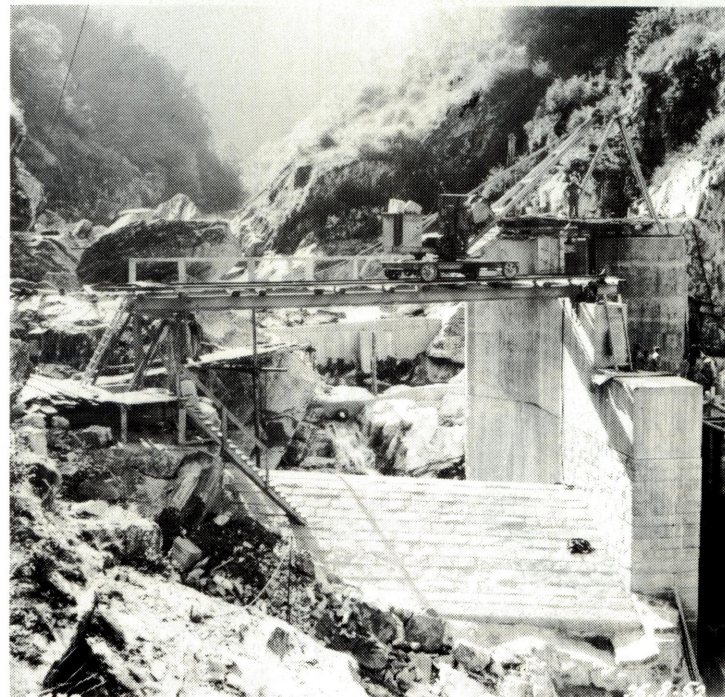
25 agosto 1952: la presa in costruzione
