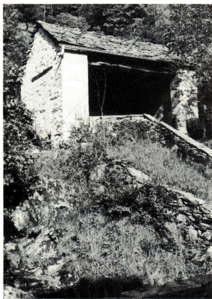
Auressio, il lavatoio comunale. La lapide affissa al muro recita: «Lavatoio fatto costruire per utilità pubblica nel 1895 dal Consigliere Paolo Antonio Calzonio».
