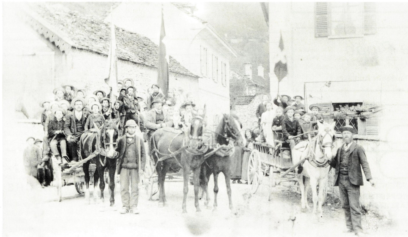
Foto ricordo eseguita a Cavigliano il 2 maggio 1898 in occasione del centenario della Scuola per Ragazzi di Loco fondata appunto nel 1798 col Legato Peverada. Il conducente di sinistra era Pietro Zenone e quello di destra Carlo Degiorgi.
