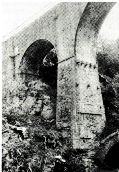
Ai piedi dei piloni del Ponte Scurio due volontari onsernonesi al lavoro.
