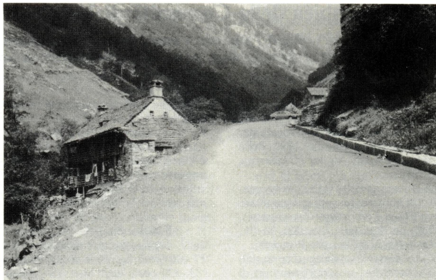
La strada agricola della Camana è stata di recente prolungata e asfaltata. La strada, che parte dal Zardin e termina all'ex bacino idroelettrico in Val Camana, si presenta ora comoda e scorrevole ed è dotata, al terminale, di un piccolo posteggio e una piazza di giro.
