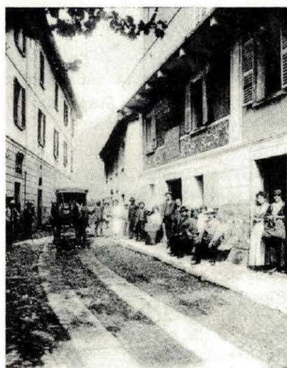
LOCO - Valle Onsernone Albergo - Negozio con prestito Prop. SCHIRA ACHILLE
