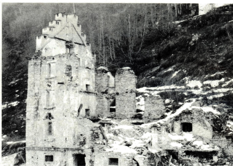
I ruderi dell'Albergo dei Bagni oggi. Nello scantinato si trova la grande vasca in pietra e la sorgente la cui temperatura di 28 gradi e il tasso di mineralizzazione sono rimasti invariati nei secoli. Con una certa difficoltà vi si può ancora accedere dato che l'enorme spessore dei muri di fondazione e le volte — risalenti, sembra, al 1420 — hanno resistito alla valanga del 1951. Tuttavia lo stato precario delle pericolanti macerie che sovrastano la preziosa fonte ne rende viepiù rischiosa l'accessibilità.
