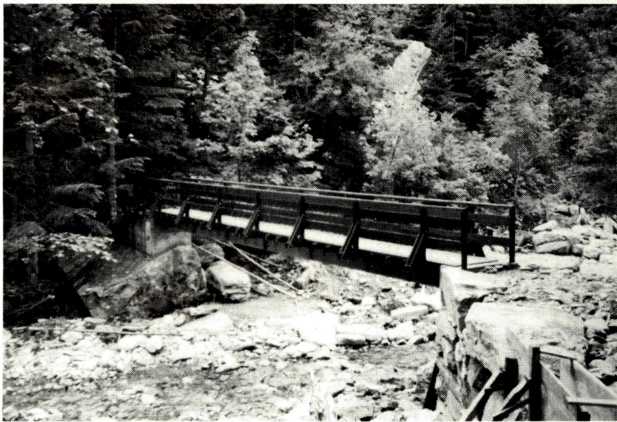
Il nuovo ponte sul Ribo costruito dai Volontari
