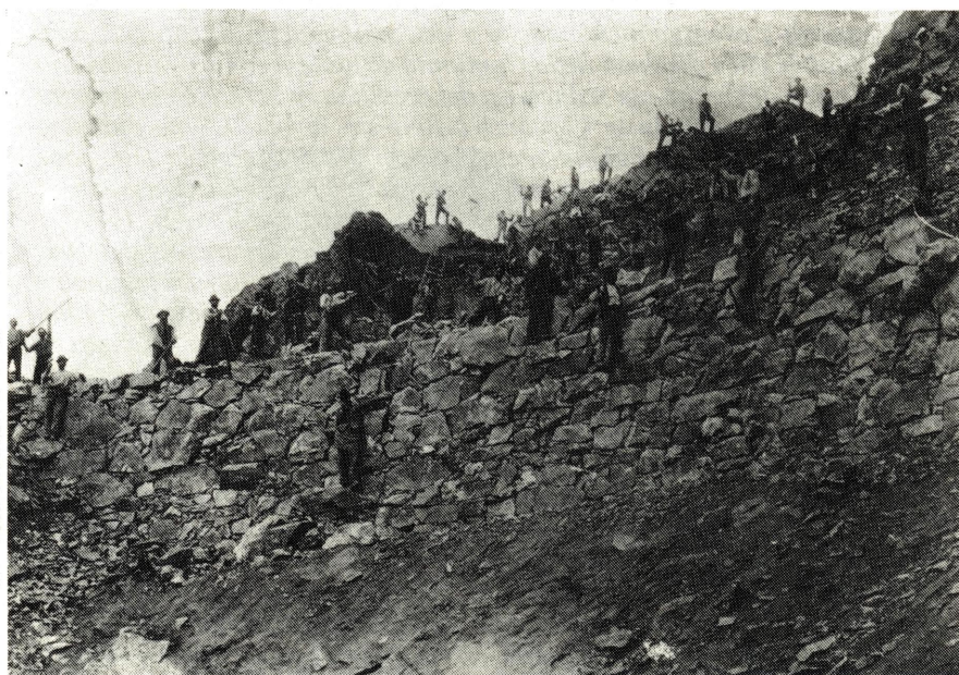
Ferrovie BB - Pontresina-Morteratsch-Schlarigna-Pontresina inaugurata nel 1908. Operai Mosognesi al lavoro.
