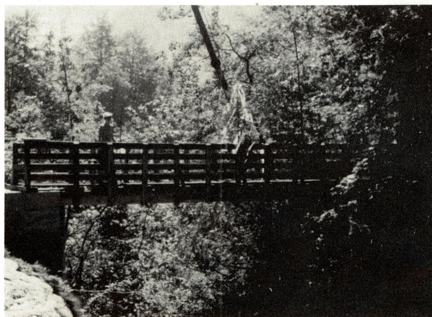
Comologno: il nuovo ponte della Centrale ricostruito dai giovani volontari della Croce Rossa.
