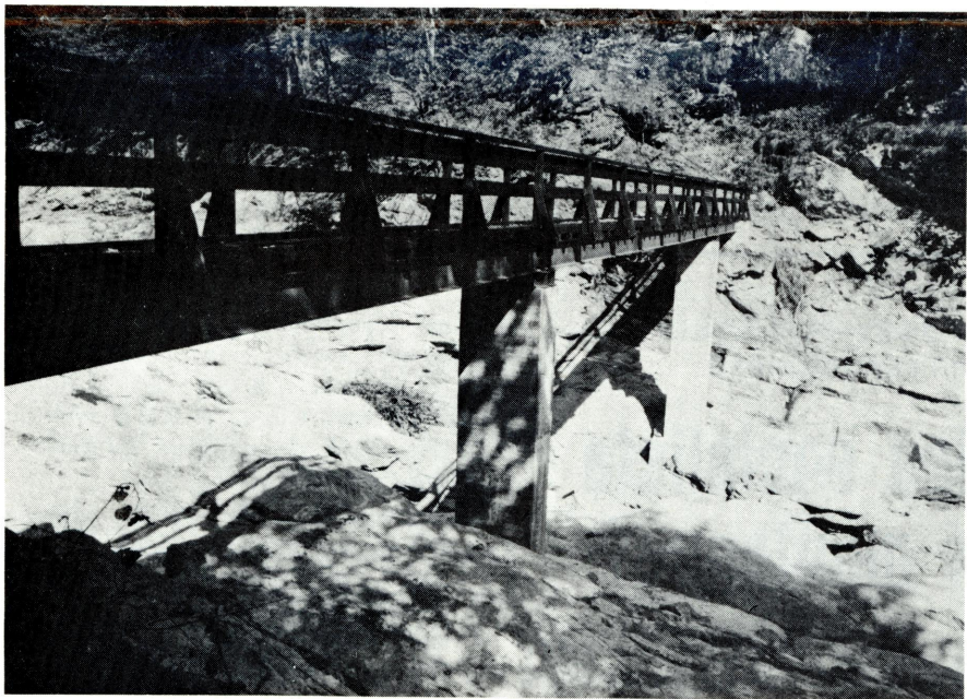
Un importante lavoro fatto dai militari dopo l'inondazione.
