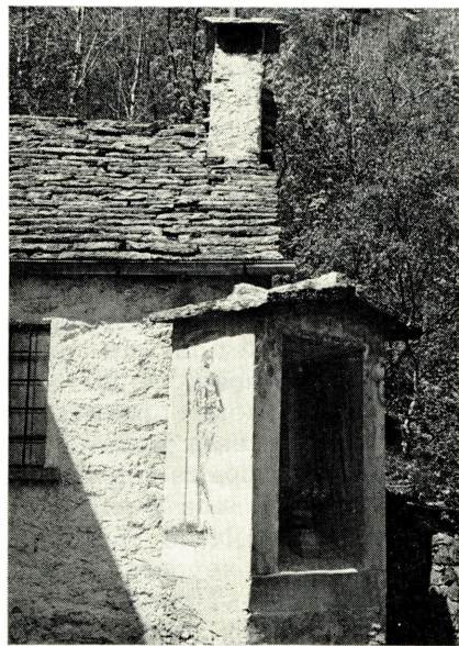
Cappella accostata all'Oratorio delle Vose, con pittura simboleggiante la morte.
