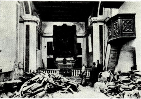
Oratorio di Mosogno Sotto o dell'Addolorata, Crollo del 1939. Foto Steinemann
